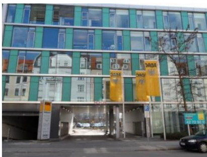
A: Einfahrt in den Innenhof
